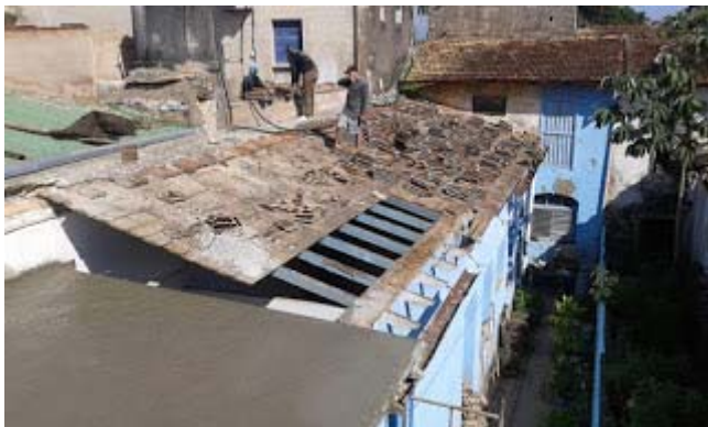
Sanierung des Kirchendaches
